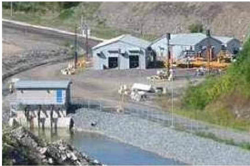
Bâtiments des compresseurs pompant les biogaz
