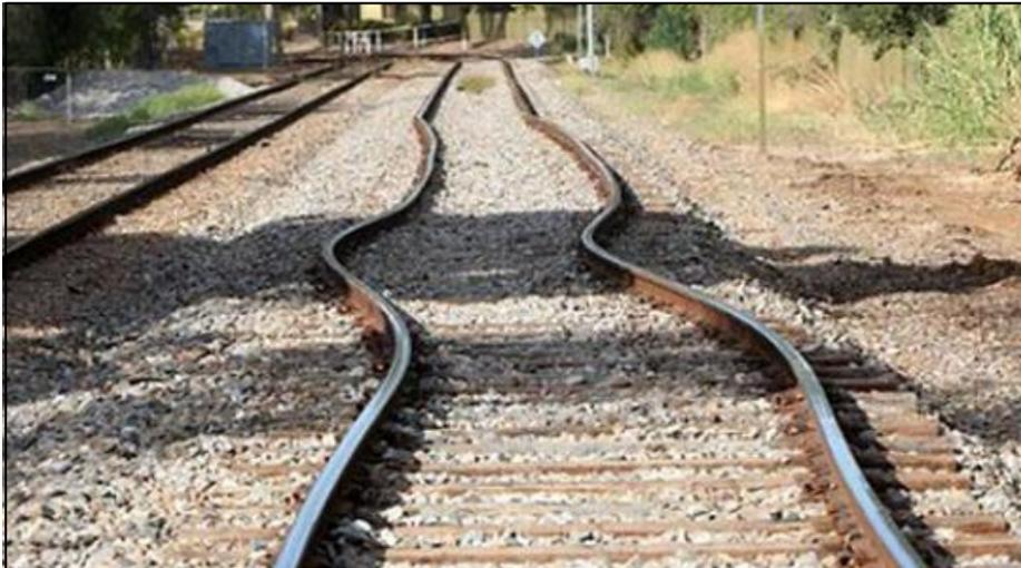
Flambement d'un rail causé par l'élévation de température
