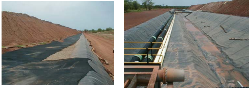
Figure 23 a & b : Cyanuration en tas sur géomembrane. Mine de Yatela
