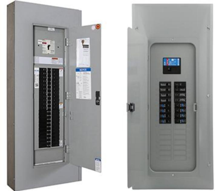
Exemple d'armoire de distribution : chaque disjoncteur est un circuit
