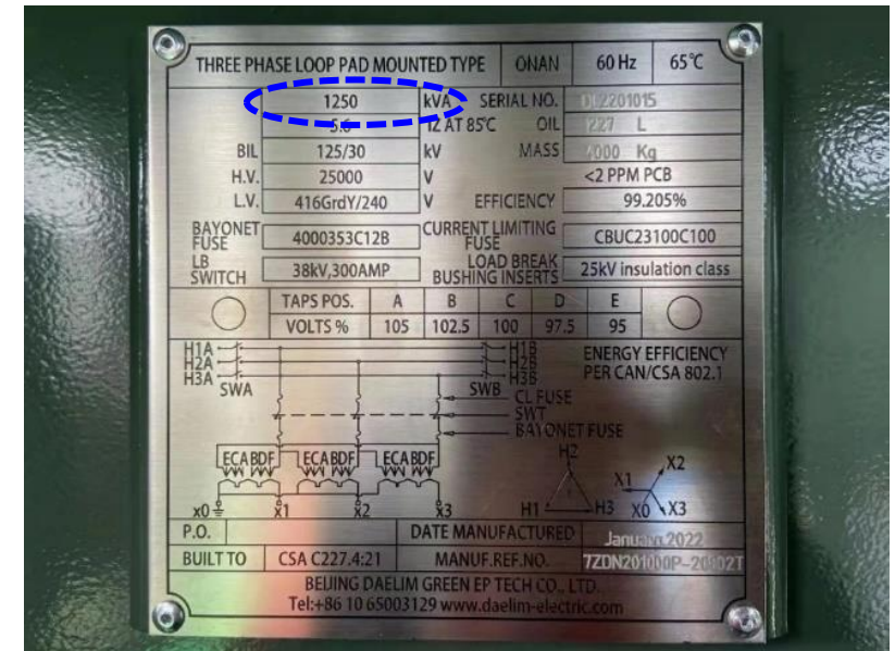
Plaque signalétique d'un transformateur triphasé 1250 kVA
